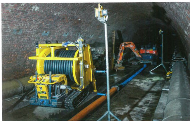
VDV cleaning maakt voor rioolreiniging en -inspectie gebruik van de meest geavanceerde technieken.
